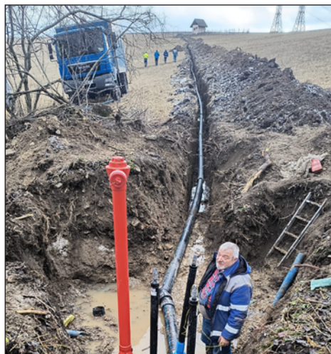
Od stredy 12. februára do utorka 18 februára 2025 prebiehali opravy viacerých poruch na dodávke pitnej vody. Najväčším problémom bolo popraskané potrubie medzi zberačom prameňov a vodojemom. Pracovníci Vodární vymenili 350 m potrubia.
