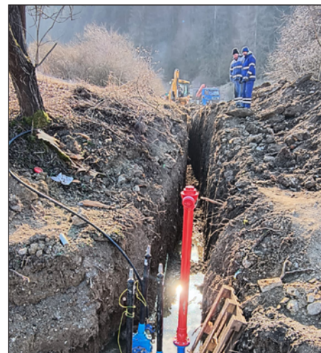
Od stredy 12. februára do utorka 18 februára 2025 prebiehali opravy viacerých poruch na dodávke pitnej vody. Najväčším problémom bolo popraskané potrubie medzi zberačom prameňov a vodojemom. Pracovníci Vodární vymenili 350 m potrubia.
