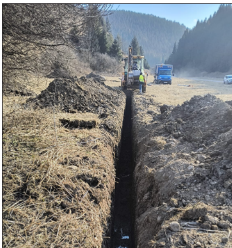
Od stredy 12. februára do utorka 18 februára 2025 prebiehali opravy viacerých poruch na dodávke pitnej vody. Najväčším problémom bolo popraskané potrubie medzi zberačom prameňov a vodojemom. Pracovníci Vodární vymenili 350 m potrubia.
