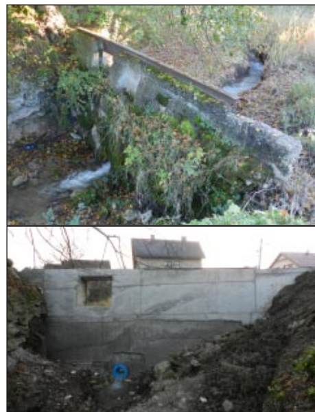
Hrádza rybníka pred rekonštrukciou a v jej priebehu foto: D. Dírer
